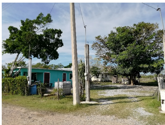
Figura xxx. Cableado para servicios de telecomunicaciones
